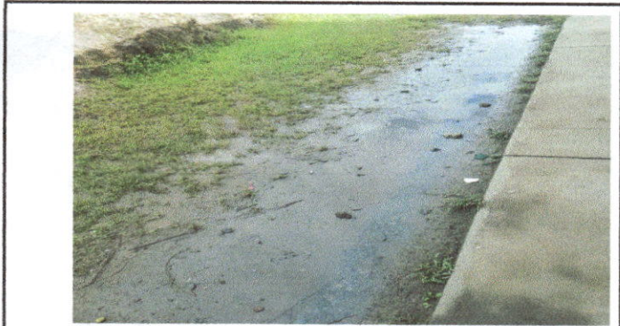
Foto 3: Losa de patio
