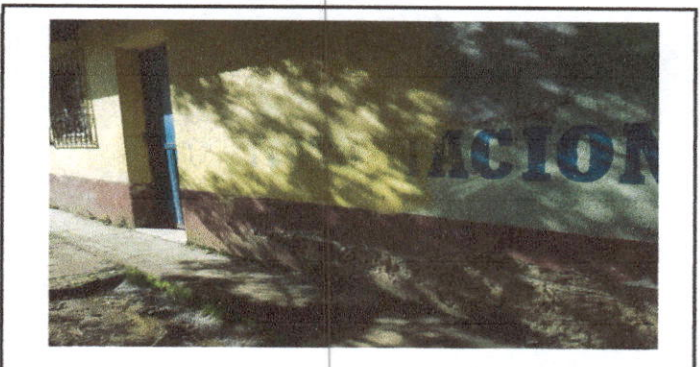
Foto 4: Reparación de repello y cernido de paredes
