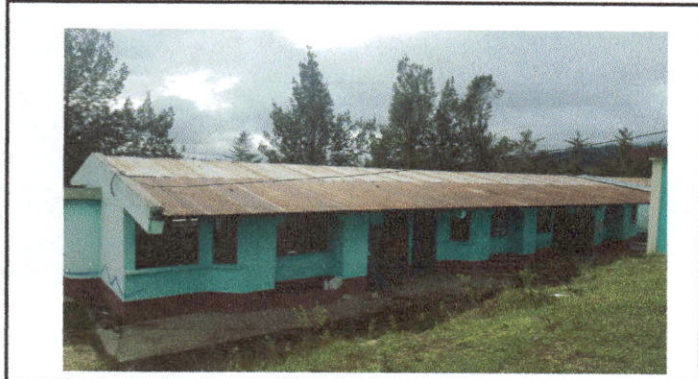
Foto1: Cubierta de lamina
