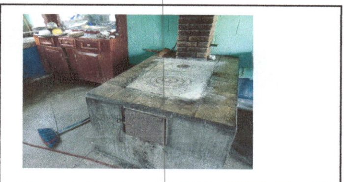
Foto 6: Reparación de cocina
