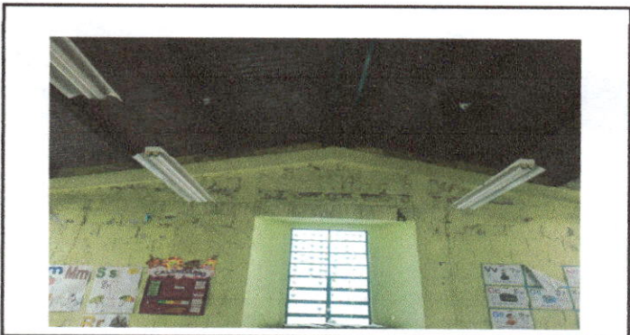
Foto 5: Reparación de sistema Eléctrico
